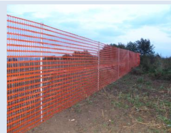
Einsatz von temporären Zäunen während der Bauphase
