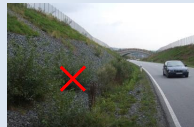
Gehölze strassenseitiger Raum entfernen
