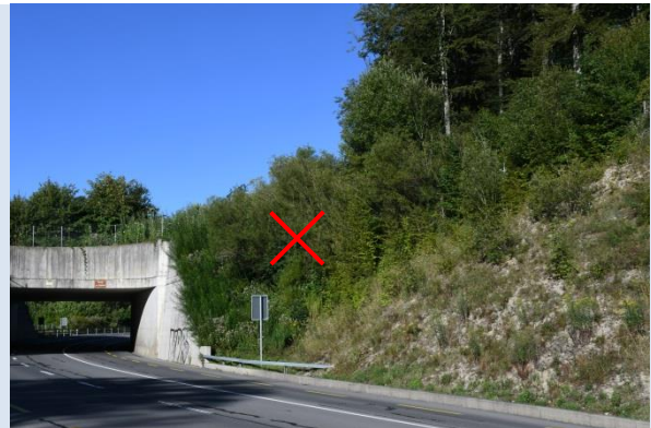
Die Entwicklung von Büschen an den Böschungen zwischen Zaun und Fahrbahn leitet die Fledermäuse neben der Überführung durch und erhöht somit das Kollisionsrisiko stark
