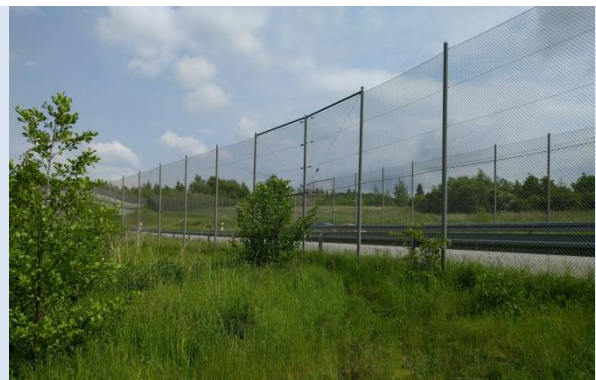
Gitterzaun, welcher Fledermäuse zu einem Querungsbauwerk führt
