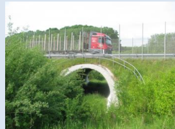
Enge Anbindung der Leitstruktur an die Unterführung
