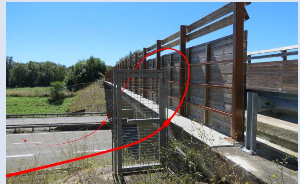
Negatives Beispiel : aufgrund des versetzt zum Bauwerkseingang angeschlossenen Zauns besteht ein erhöhtes Risiko, dass die Strasse überflogen wird
