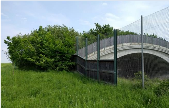
Positives Beispiel : fachgerechter Anschluss des Zaunes auf Höhe des seitlichen Blendschutzes; niedere Hecke dient als Leitstruktur auf dem Bauwerk
