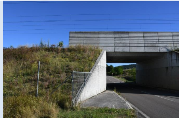
Anschluss des Zauns im unteren Teil des Eingangs einer grossen Unterführung
