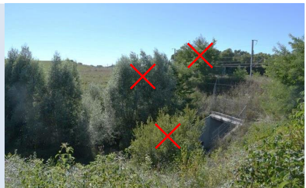
Entwicklung von grossen Bäumen in der Leitstruktur und Büsche auf den Böschungen bewegen Fledermäuse dazu, die Infrastruktur eher zu überfliegen als die Unterführung zu nutzen; verhindern dass Büsche den Eingang des Bauwerkes versperren
