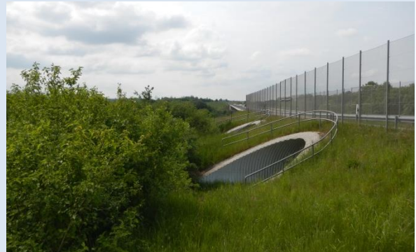
Zaun, der die Fledermäuse dazu bewegt die Unterführung zu nutzen oder die Strasse oberhalb des Verkehrs zu queren
