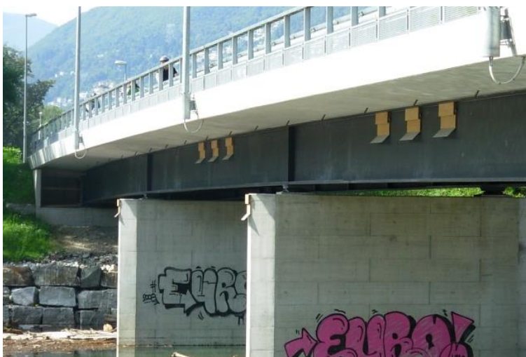
Abbildung 17: Montierte Fledermauskästen an einem Stahlträger einer gewässerquerenden, modernen Brücke (© Marzia Mattei).
