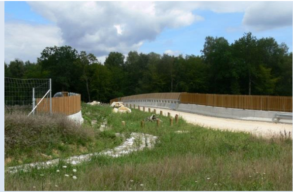
Seitlicher Blendschutz, beidseits trichterförmig verlängert, gesäumt von Pflanzungen und korrekt mit den angrenzenden Zäunen verbunden
