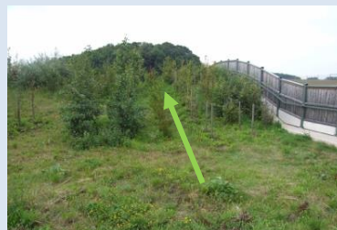
Gehölzschnitt in der Mitte der Wildtierbrücke, damit Flugschneisen entstehen
