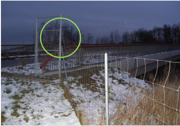
Positives Beispiel : korrekter Anschluss des Zauns am Eingang eines Querungsbauwerkes
