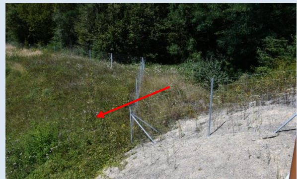
Negatives Beispiel : Der Zaun weicht am Böschungsfuss ab und bildet einen tiefen Punkt, der von Fledermäusen leicht überflogen werden kann
