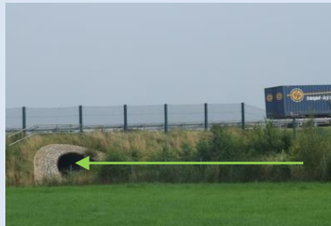
Heckenleitstruktur zur Unterführung Hamco Borna
