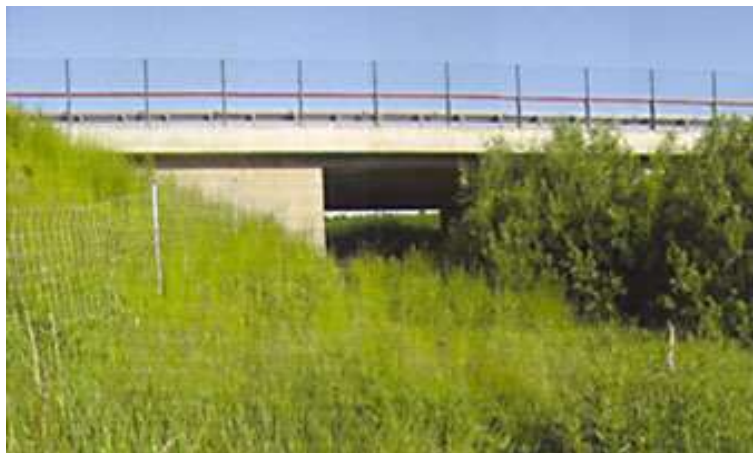
Abb. 2: Eine Unterführung als Querungshilfe für Fledermäuse. Hecken führen beidseits an die Unterführung heran. Zäune entlang der Trasse und flankierend zu den heranführenden Strukturen verhindern, dass Fledermäuse über die Strasse queren. Unter der Brücke führt ein Bach hindurch, diese Querungshilfe eignet sich also auch für Amphibien. Quelle: Brinkmann et al., 2012 .
