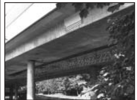
Am Stieg des Brückenhohlkörpers wurden im Zuge der Sanierung 18 Fledermauskästen montiert. Blick von der Manessestrasse aus. Die Kästen sind aus Fichtenholz, je 3 m lang und 1.20 m hoch. Sie weisen drei Kompartimente auf mit Spaltenweiten von 15 mm, 25 mm bzw. 35 mm. So finden kleine und grosse Fledermausarten Unterschlupf.
