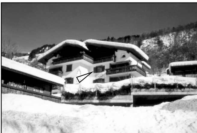
Die Mopsfledermäuse hielten sich an diesem 1991 erbauten Mehrfamilienhaus hinter dem linken Fensterladen (Pfeil) auf.
