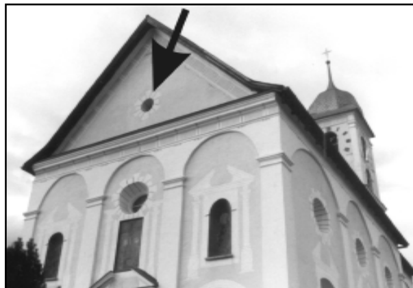
Seit der Scheinwerfer der Kirchenbeleuchtung nicht mehr in die Ausflughöffnung (vgl. Pfeil) leuchtet, fliegen die Mausohren deutlich früher zur Insektenjagd aus. Die potentielle Jagdzeit der Kolonie hat sich dadurch bedeutend verlängert.
